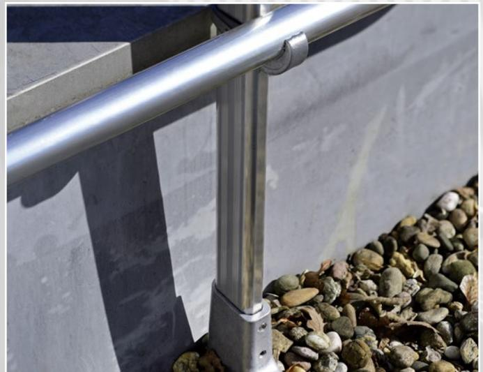
Sollte keine Attika > 150 mm oder ähnliche bauliche Abtrennung zwischen Geländer und Absturzkante liegen, besteht die Möglichkeit, mit einer Fußleiste aufzurüsten. / If there is no parapet > 150 mm or a similar construction to provide a division between the rail and the roof edge, a kickboard can be used.
