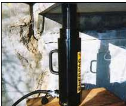
◀ Die tragbaren RACL-1506 Zylinder mit Sicherungsmutter dienen zur langfristigen Lastaufnahme bei der Epoxideinspritzung im Rahmen der Brückenverstärkung.
