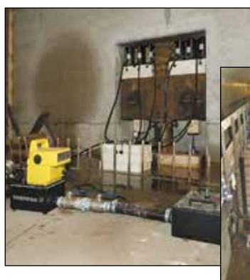
Die einzigartige RA-Zylinderserie von Enerpac – leicht und vollständig aus einer Aluminiumlegierung gefertigt – diese RAC-506 Zylinder eignen sich ideal zum Versenken und Positionieren von Tunnellementen unter Flussläufen für das niederländische HSL-Projekt (Hochgeschwindigkeits-Bahnlinie).
