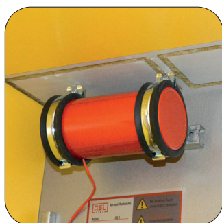
Aerosol-Löschgenerator
