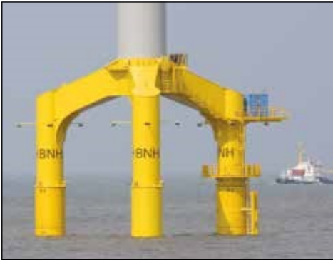
▲ Ausrichtung von Offshore-Windturbinen: Einsatz des Synchronhubsystems von Enerpac zum Ausgleich der tragenden Querstreben von 80 Windturbinen.
