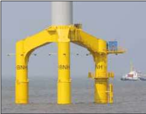
▲ Ausrichtung von Offshore-Windturbinen: Einsatz des Synchronhubsystems von Enerpac zum Ausgleich der tragenden Querstreben von 80 Windturbinen.
