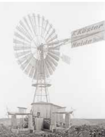
Windkraftanlage zur stationären Stromerzeugung - KÖSTER-Innovation im Zeitalter der Industrialisierung
