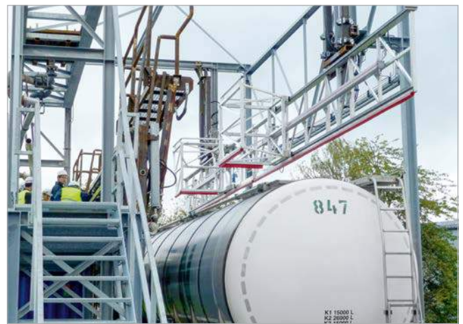
Höhenverstellbarer Geländerkäfig
