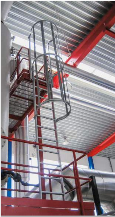
Steigleiter als Maschinenzugang
