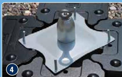
④ Setzen Sie den Anschlagpunkt und die Basis auf die L-Bolzen und Platten
