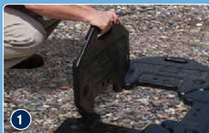
① Richten Sie die gummierten Platten mit Hilfe der Schablone in einem Quadrat aus
