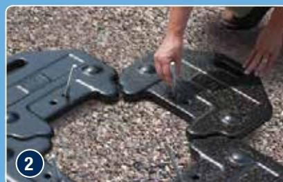
② Schieben Sie die L-Bolzen in die Slitze an den gummierten Platten
